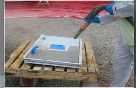
Aluminum Access Door Vapor Blasting
