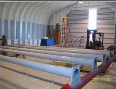
Light Poles Epoxy Primer Urethane Finish
